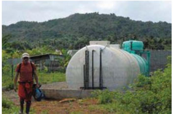
**Figure 1 :** Le décanteur-digester
